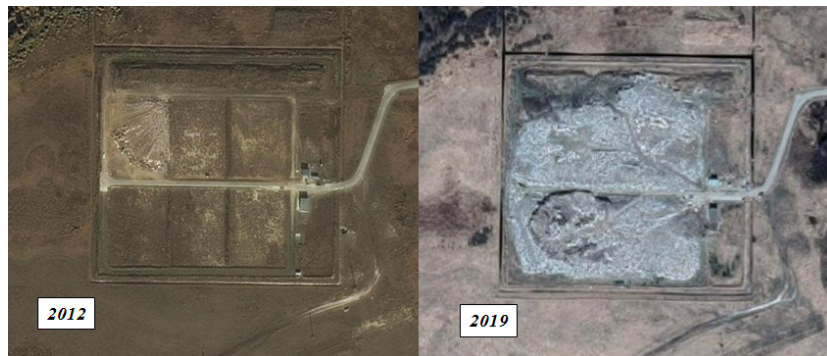
Рис. 5. Разновременные изображения полигона ТБО вблизи г. Ялutorовск
